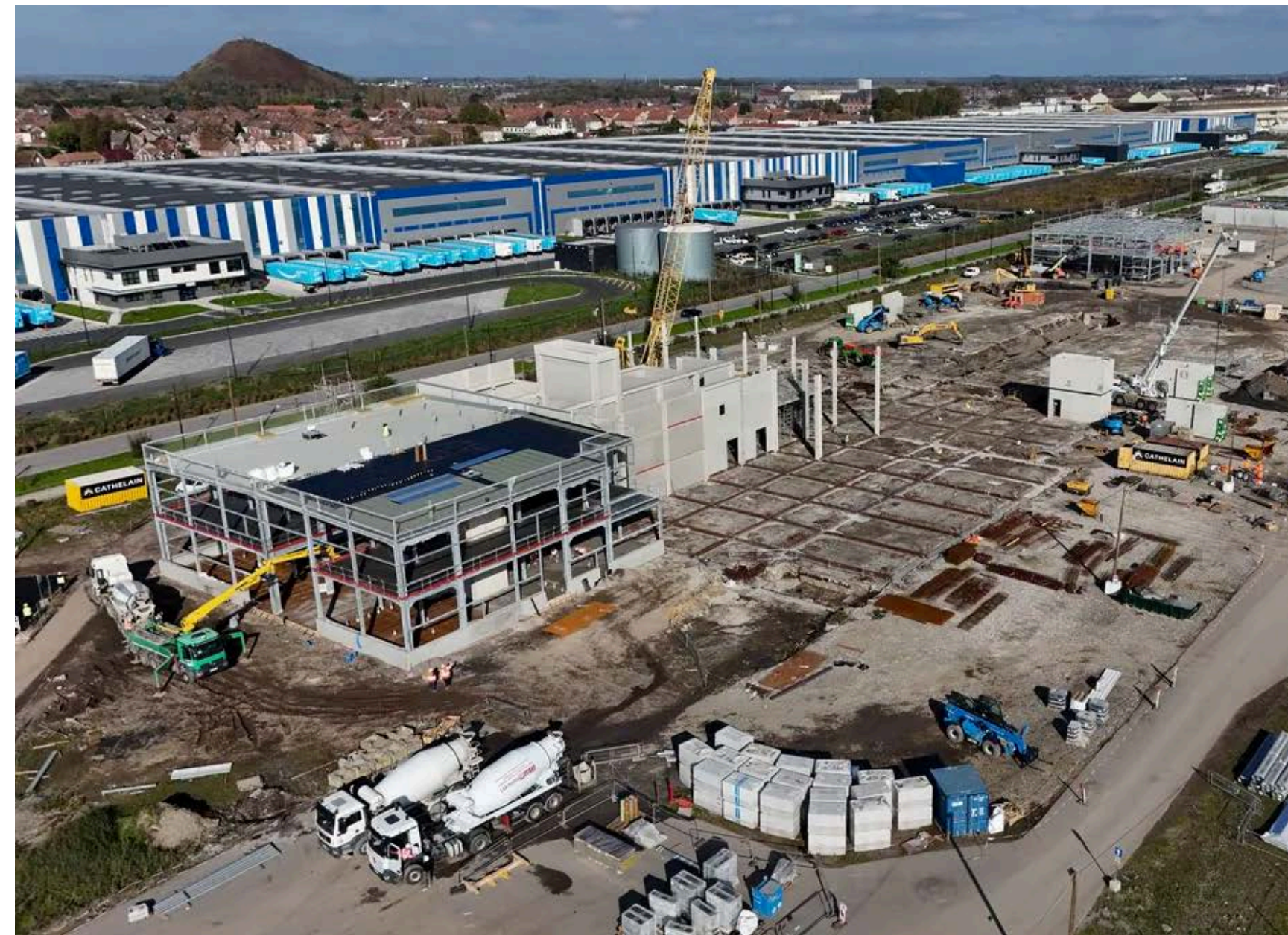
Installation de l'entreprise Lesaffre dans la zone des Pierres Blanches à Denain, 2025.
